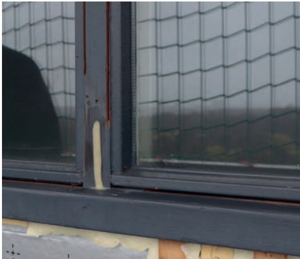
De kozijnen worden ingezaagd, om het glas inclusief asbesthoudende kit snel te kunnen verwijderen en te vervangen door nieuw isolatieglas.
