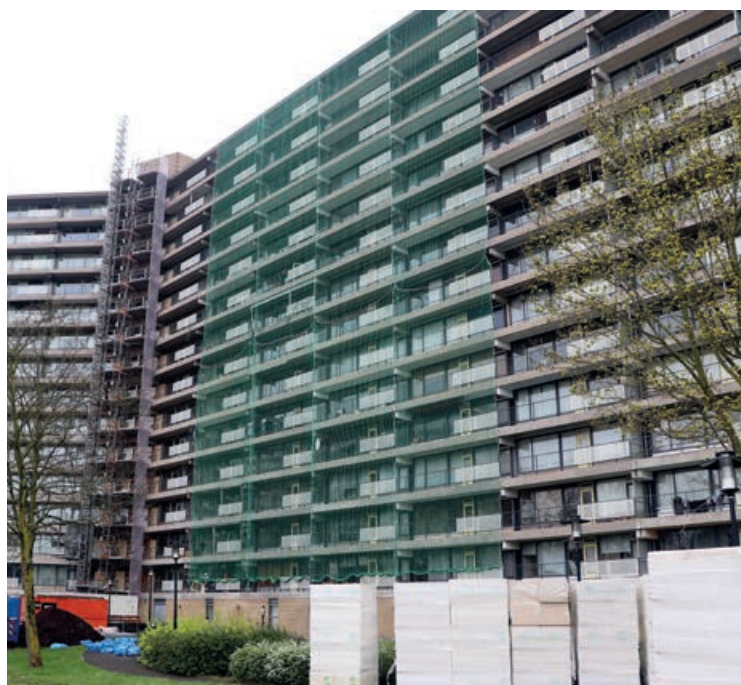
Langs het deel waar gewerkt wordt, hangt Team ERAflats netten op voor extra veiligheid bij het werken op het balkon en als bescherming tegen vallende spullen.
