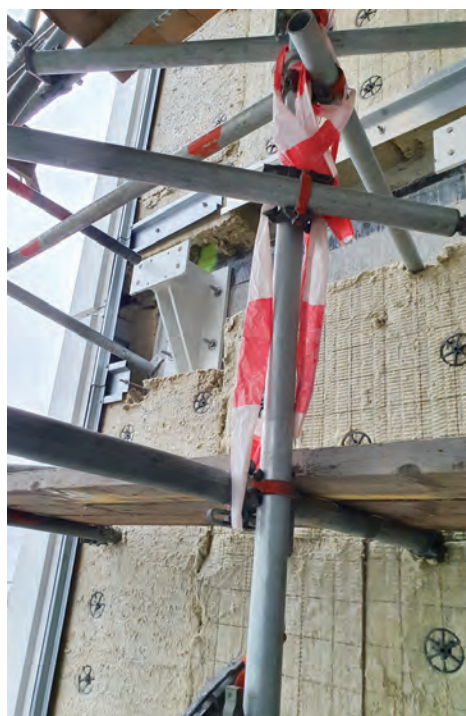
De microbeton balkonplaten steunen met stalen hulpstukken af op het betoncasco van de toren.
