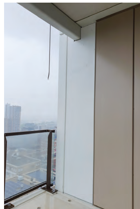
Aan een ondersteuning met een stalen balk viel constructief niet te ontkomen.
