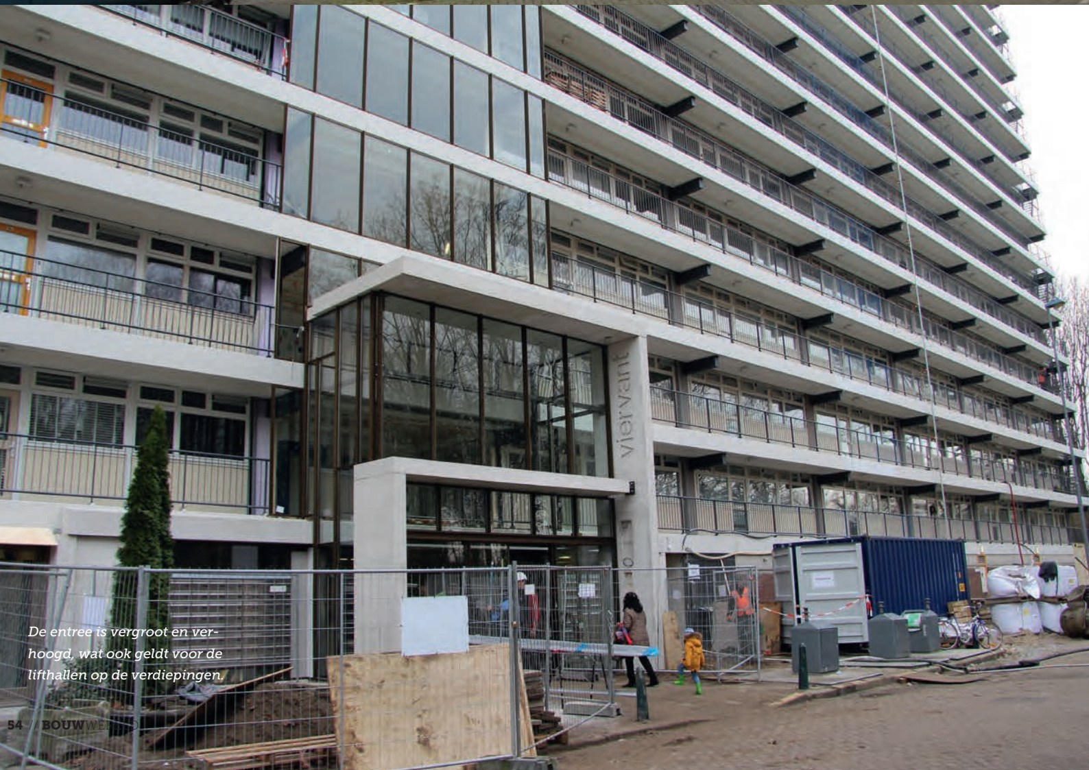
De galerijgevel van de Viervant-flat vóór renovatie, met de oude kleine entreepartij.
